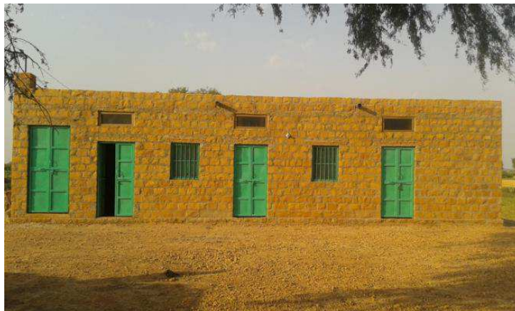
Bâtiment terminé, composé de 2 pièces
