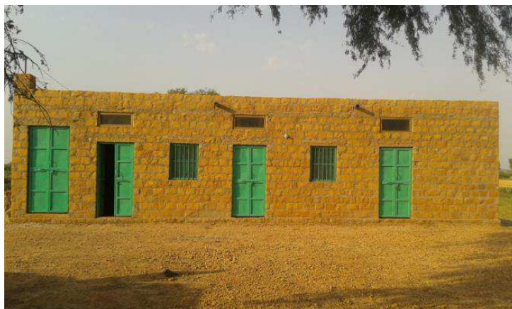
Bâtiment terminé, composé de 2 pièces
